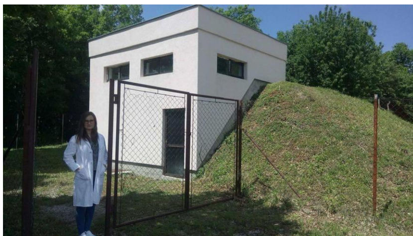
Slika 9. Lokalni vodovod Cukovec 1 Izvor: autor
