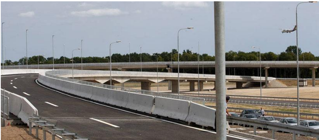
Slika 13. Betonska zaštitna ograda New Jersey
