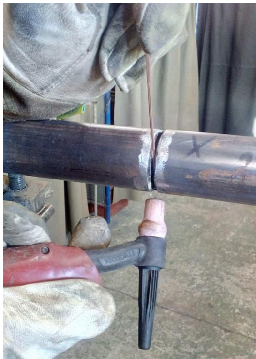
Slika 38. Namještanje elektrode i dodatnog materijala
