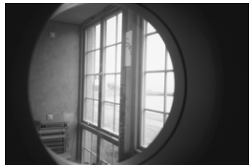
Fallstudie Stumholmen. Fönster i vardagsrummet, in mot loggian.
