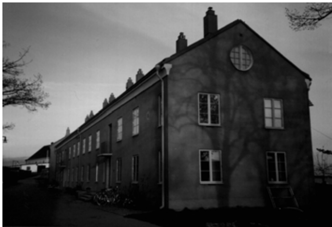
Västra Kungshall, gavel mot väster.
