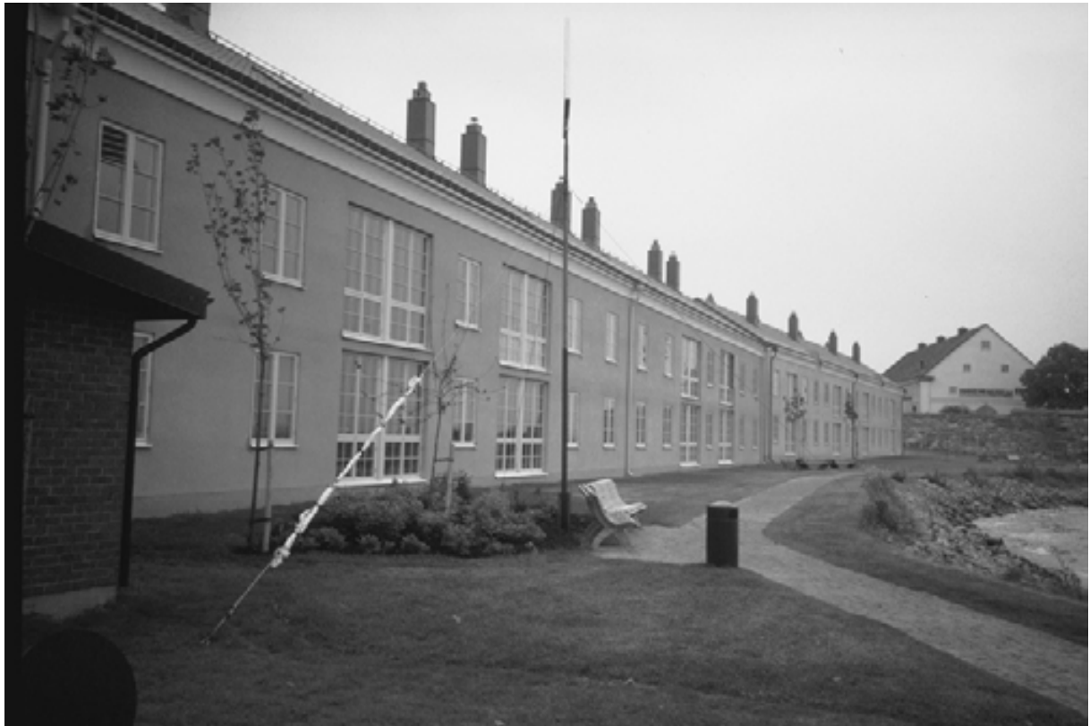
Västra Kungshall, Stumholmen från söder. Foto: Göran Peyronson.
