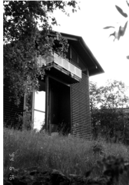
Gränsrum. Fallstudie Hestra. Glaspartiet, två våningar högt, framför rummet i bjälklagsöppningen.
