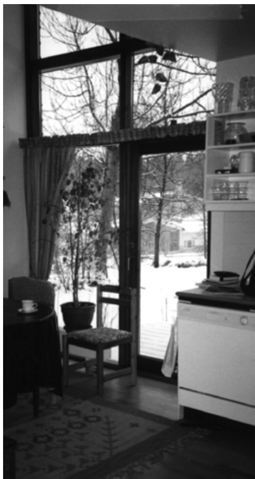
Öppningen i bjälklaget, bild från kök och matplats i 3 rumslägenheten.
