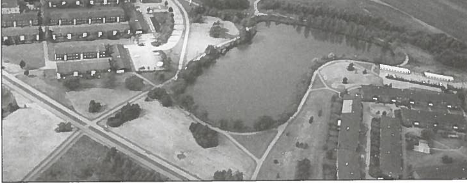
Figur 9. Vallås båda dammar som exempel på en djupare sedimentationsdamm (syns i förgrunden) som följs av en grundare vegetationsdamm. Sedimentationsdammen anlades under 1960-talet samtidigt som omgivande bebyggelse och syftade primärt till att utjämna dagvattenflödet. Vegetationsdammen tillkom 1992. Foto: Sven-Erik Jönsson.
