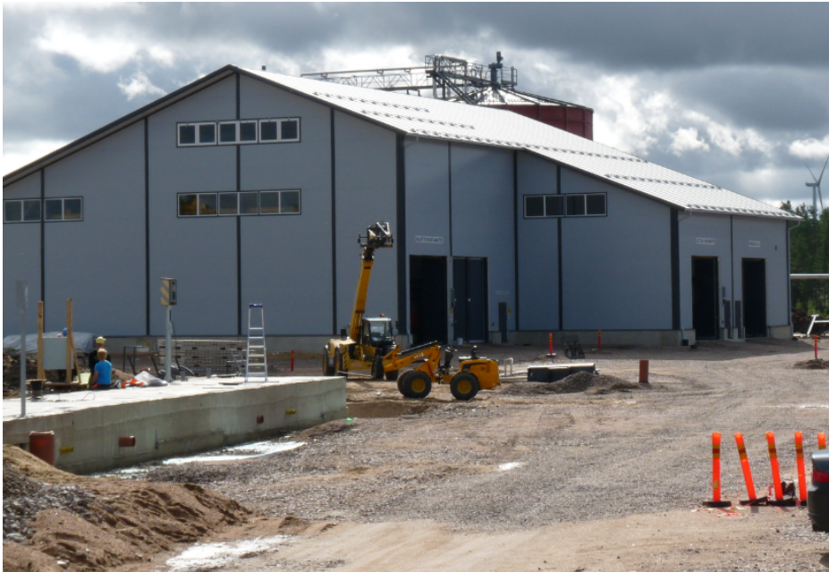
Kuva 15. Rakenteilla (elokuussa 2014) oleva Honkajoen biokaasulaitos.
