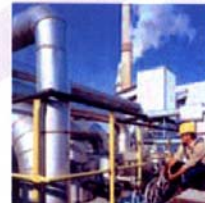
Modernisierung von vier braunkohle-gefeuerten Kraftwerksblöcken
