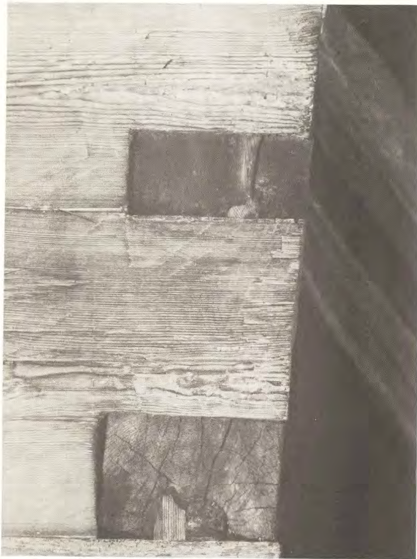
Figur 67. Knutar i tornet i Pelarne kyrka (från tiden före 1350). Foto 1985.
