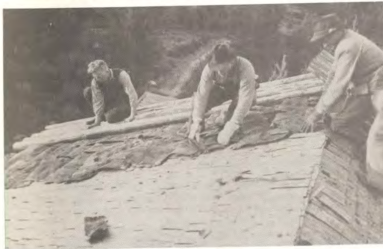
Figur 101. Näver- och vedtäckning på ett gammalt pärttak. Foto Norrbottens museum.
