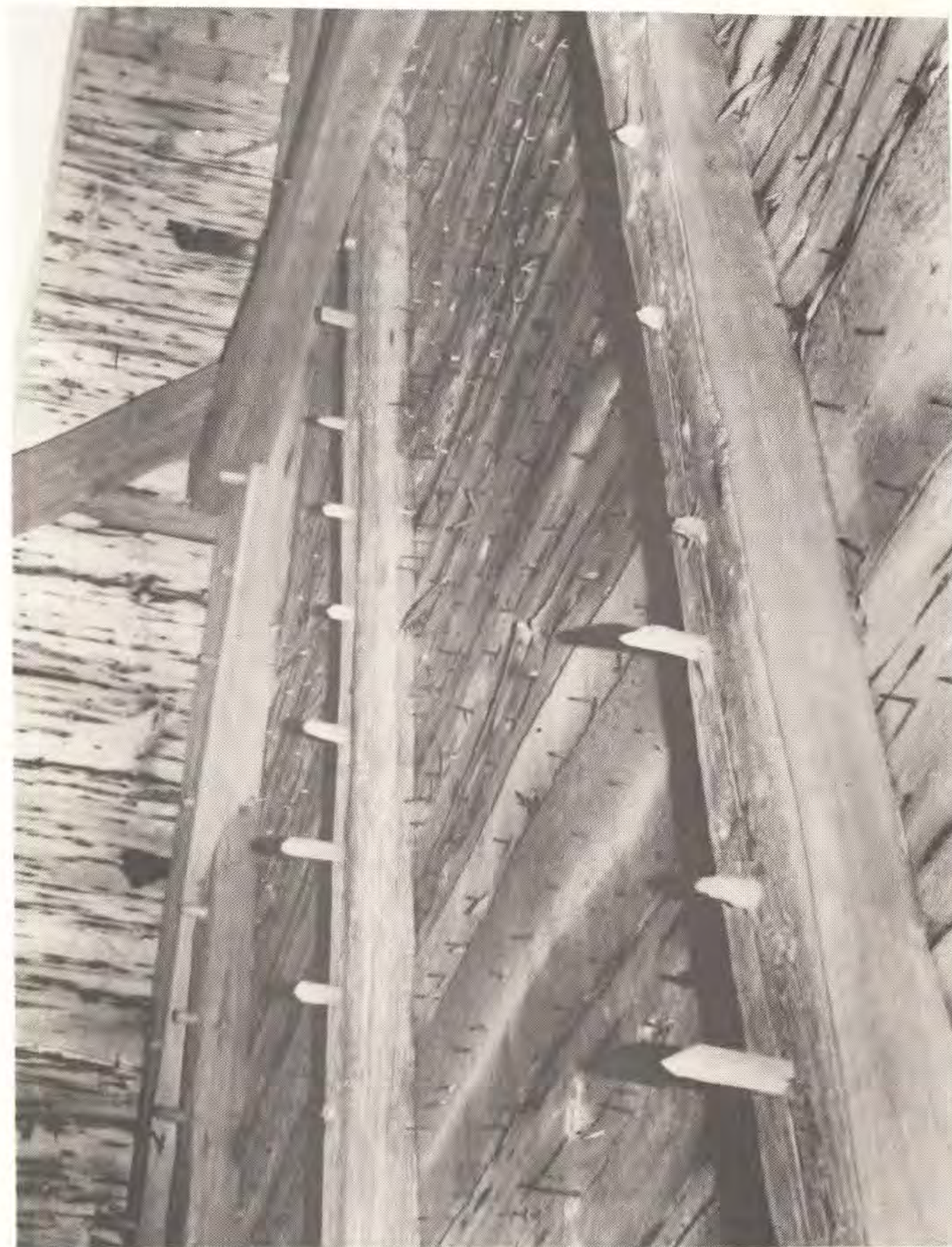
Figur 33. Granhults kyrka (1220-tal). Västgaveln. Foto 1986. Brädorna är troligen ursprungliga. De är fastsatta med
