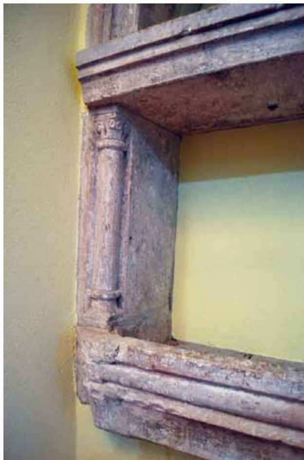
44 Kuća Vučetić, kamena polica montirana kao nadvoj (fotografija posredovanjem Agencije za prodaju nekretnina) Vučetić house, stone shelf fitted as lintel (photo provided by the real estate agency)
