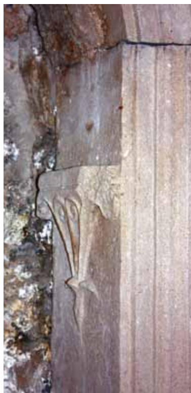
44 Kuća Vučetić, kamena polica montirana kao nadvoj (fotografija posredovanjem Agencije za prodaju nekretnina) Vučetić house, stone shelf fitted as lintel (photo provided by the real estate agency)
