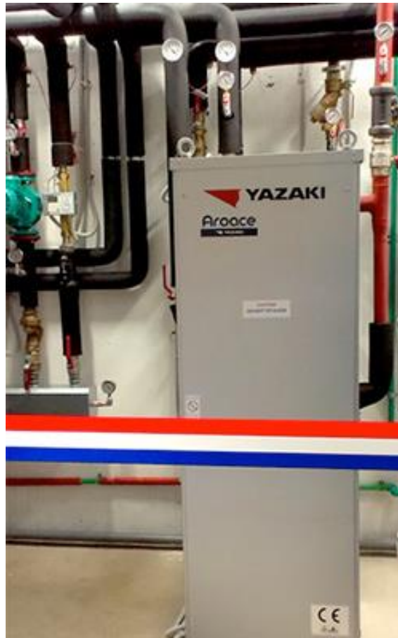
Slika 10. Apsorpcijski rashladni uređaj Yazaki WFC – SC5 rashladnog učina 17.5 kW [16]
