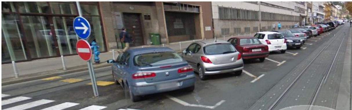
Slika 11. Središnje postavljena parkirališna mjesta u kombinaciji s tramvajskim kolosijekom, Draškovićeve ulica (Izvor: https://www.google.hr/maps/@45.8108118,15.9836732,3a,75v,327.31h,91.37t/data=!3m6!1e1!3m4!1sw28400kwioaj4xHIMTmvcQ!2e0!7i13312!8i6656 )
