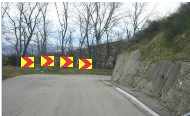
Slika 13. Nepregledni zavoј nakon izvršenja mjera
