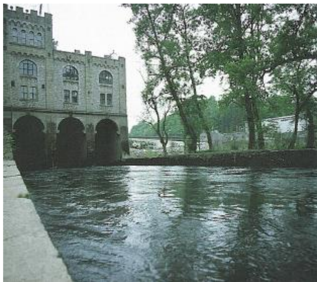
Slika 3.4 Odvodni kanal HE Ozalj I
