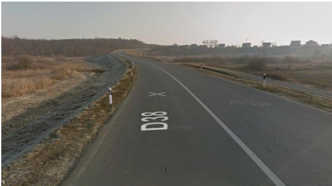
Sl. 7. Uzbrdica na cesti koja povezuje naselje Selci Đakovački s Đakovom. Pogled u smjeru naselja Đakovo.
