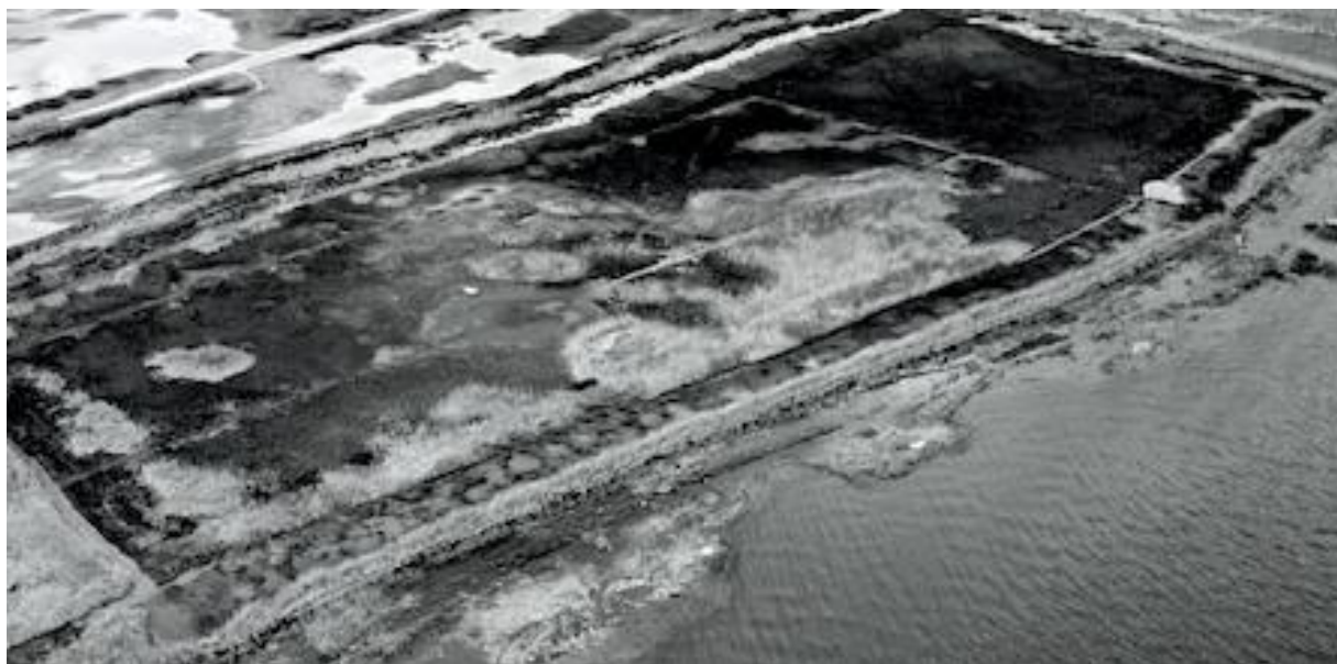
Slika 11 Prostor prve kontejnerske luke iz 1958. neposredno prije početka izgradnje
