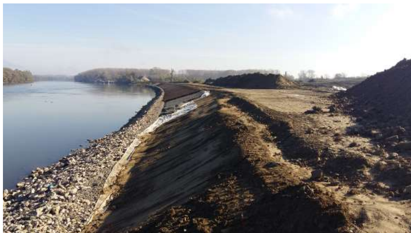
Slika 4. Izgradnja obaloutvrde (Vodovod-Osijek d.o.o., 2017) Fig. 4. The coastal defense construction (Vodovod-Osijek d.o.o., 2017)
