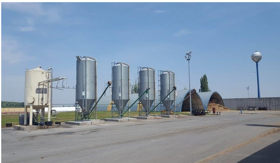
Slika 11. Vertikalni silosi za smještaj hrane
