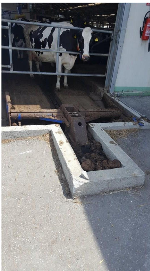
Slika 9. Uređaj za izbacivanje gnoja iz staje
