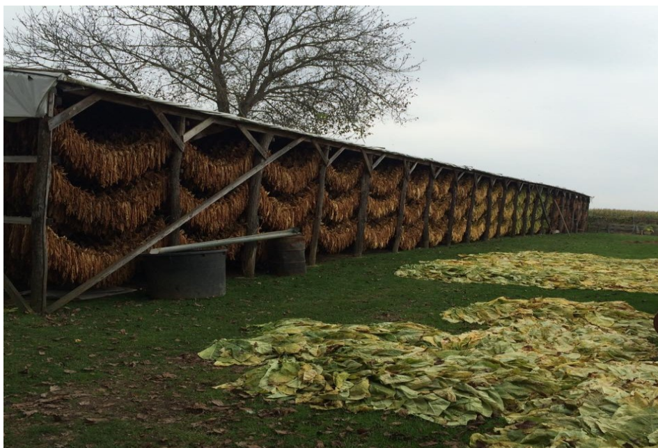
Slika 4. Sušara s drvenom konstrukcijom u tri etaže
