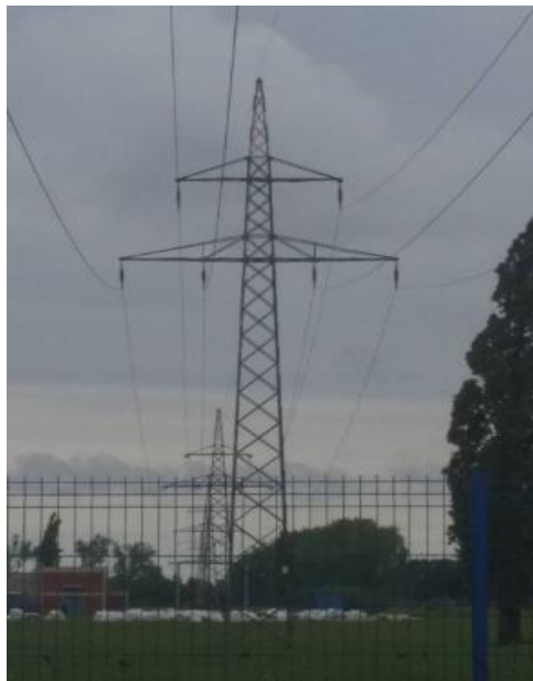
Sl.2.9. Dvostruko čelično-rešetkasti stup, oblik "Dunav"
