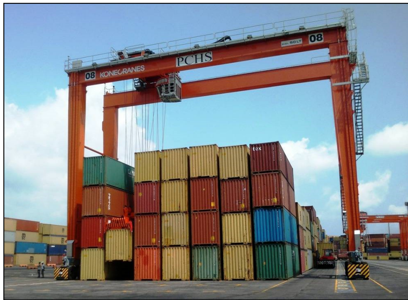
Slika 8 Kontejnerski blok slagališta opremljen RTG dizalicom
