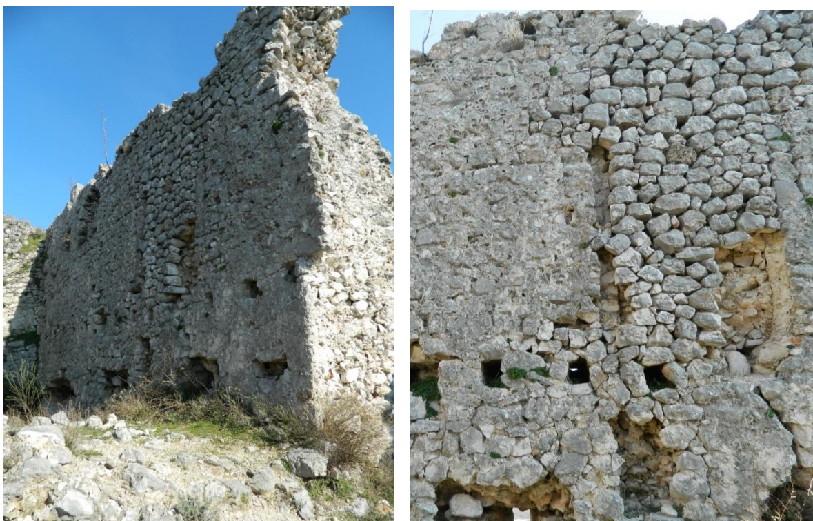
Slike 128 i 129: Pogled na istočni zid malog obora i desno na tom zidu vidljivi rubnjak lijevog starijeg zida ispod 'nalijepljene' oplata (foto: N. Čuljak).
