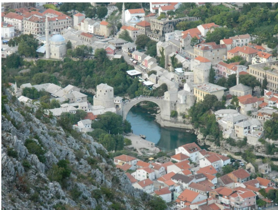
Slika 137: Pogled na Stari grad u Mostaru sa brda Hum (foto: N. Čuljak).
