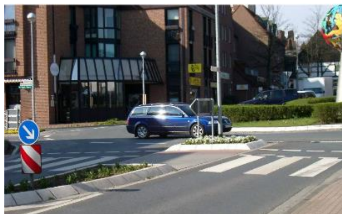
Slika 14: Pješački prijelaz na ulazu u kružni tok
