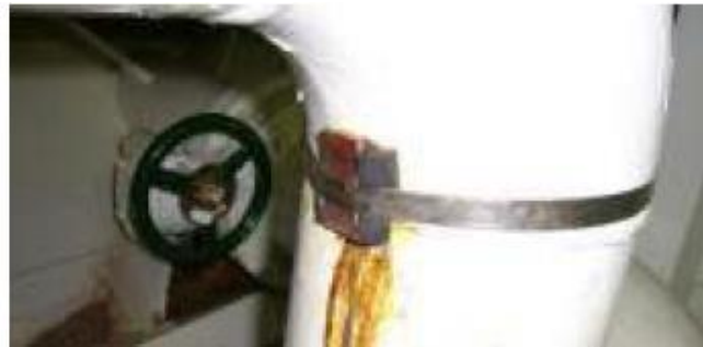
Slika 16. Oštećenja cijevi: a) cijev koju treba trajno sanirati; b) privremeni popravak (Prema: Ivošević, Špiro, Održavanje i bezbjednost broda , 2016.)
