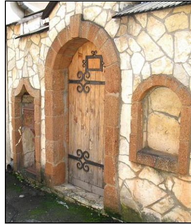
Fot. 22. Współczesny portal zlepieńcowy przy jednej z uliczek w sąsiedztwie olkuskiego rynku (fot. J. Żaba) Photo 22. Contemporary conglomerate portal at one of streets in the neighbourhood of Olkusz square market (phot. by J. Żaba)
