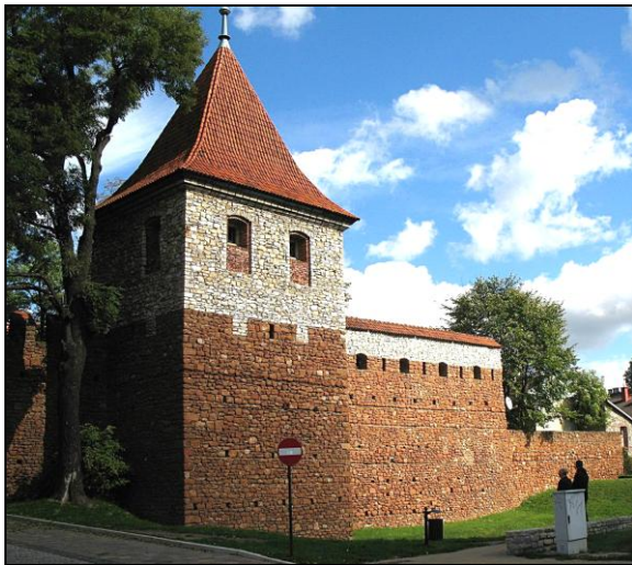
Fot. 11. Zrekonstruowana baszta i dalszy fragment murów (fot. T. Szczypek) Photo 11. Reconstructed tower and further fragment of walls (phot. by T. Szczypek)
