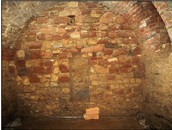
Fot. 20. Jedna z oryginalnych ścian zlepieńcowych w podziemiach byłego ratusza w Olkuszu (fot. T. Szczypek) Photo 20. One of original conglomerate walls in former town hall undergrounds in Olkusz (phot. by T. Szczypek)
