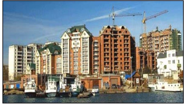
Fot. 6. Budownictwo typowe dla etapu V (fot. A. W. Kadietowa)
