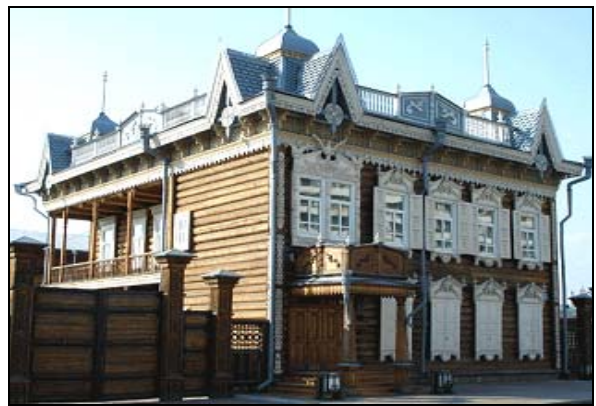
Fot. 3. Budownictwo typowe dla etapu II (fot. A. W. Kadetowa)
