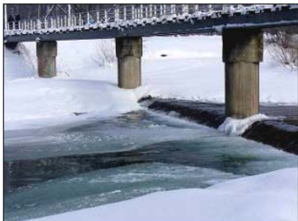
Fot. 3. Pokrywa śnieżna oraz zjawiska lodowe na rzece Koszarawie powyżej ujścia do Soły (fot. A. Piecuch, 2009). Phot. 3. Snow cover and ice events on the River Koszarawa above the mouth of the river Koszarawa to Sola (photo by A. Piecuch, 2009).
