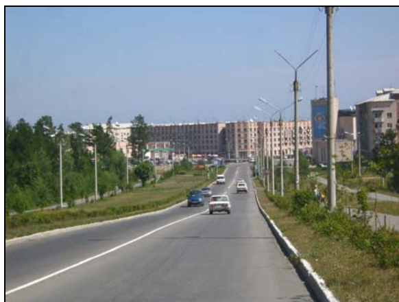
Fot. 6. Nowoczesna zabudowa Siewierobajkalska – widok z południa (fot. T. Szczypek) Photo 6. Modern buildings of Severobaikalsk – view from the south (phot. by T. Szczypek)
