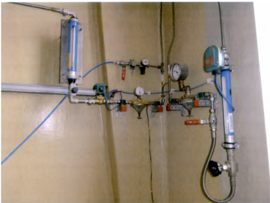
Rys. 30. Manometry, rotametry i zawory wodoru i azotu.
