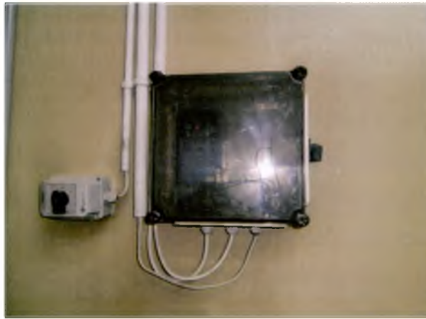
Rys. 23. Sterowanie prędkością obrotową pompy perystaltycznej (włącznik i falownik).
