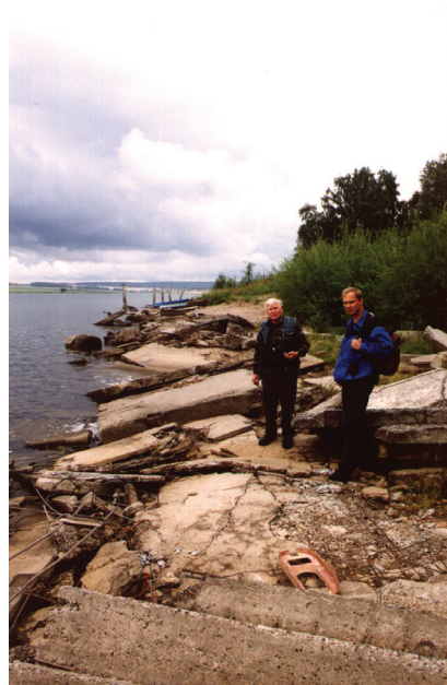
Fot. 16. Formy abrazyjne (po lewej) i zniszczone umocnienia przeciwabrazyjne (po prawej) na wybrzeżu zbiornika Irkuckiego (fot. M.A. Rzętała i M. Rzętała)
