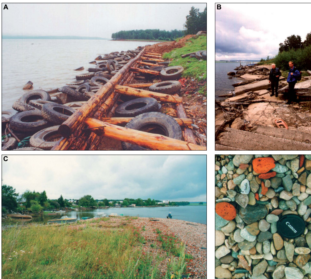
Fot. 16. Przyrodnicze i gospodarcze konsekwencje oddziaływania falowania przy różnych poziomach piętrzenia wody w Zbiorniku Irkuckim na Angarze (fot. M. RZĘTAŁA):
