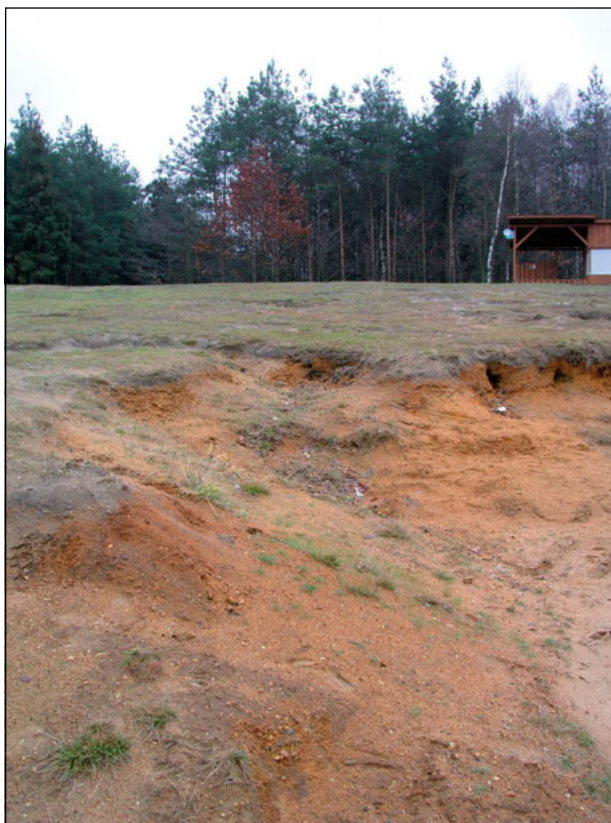
Fot. 7. Utwory piaszczyste na zachodnim wybrzeżu zbiornika Nakło-Chechło (fot. M. RZĘTAŁA)
