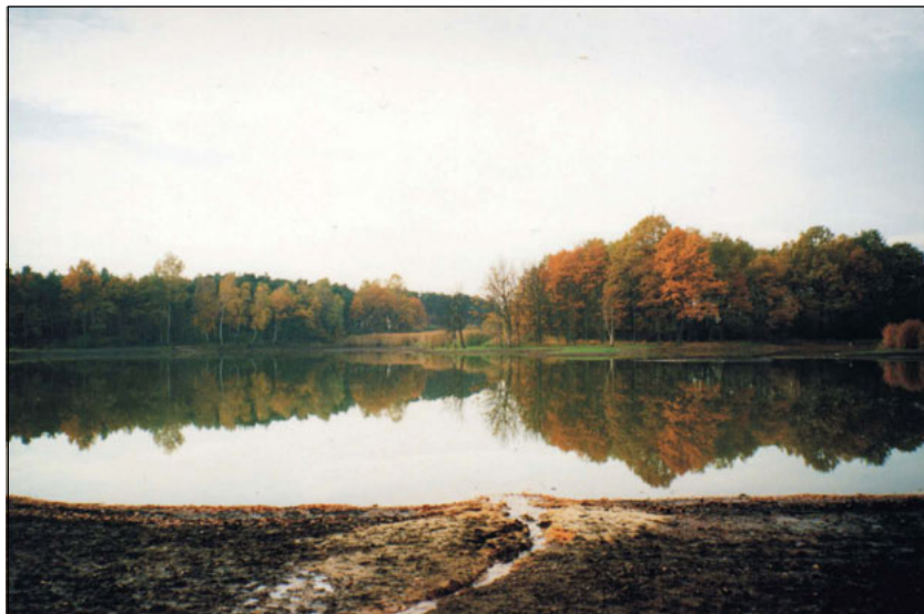
Fot. 10. Niszczona w czasie niskiego poziomu wody delta w zbiorniku nr 10 położonym w Zabrze-Makoszowach (fot. R. MACHOWSKI, 2004)
