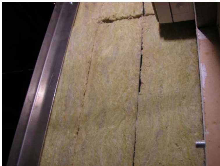
Slika 4.4. Slojevi kamene vune u gluhoj komori
