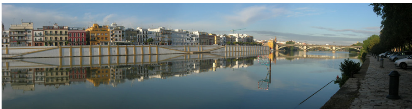
Fachada de la calle Betis. Autora: Beatriz González Sancho.
