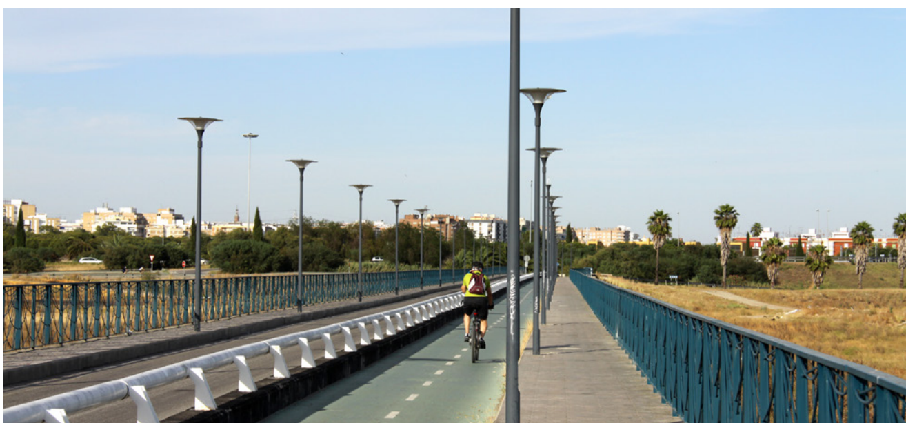
Tramo sobre viaducto tras cruzar el río en dirección a Sevilla. Autor: José María Rodrigo Cámara.
