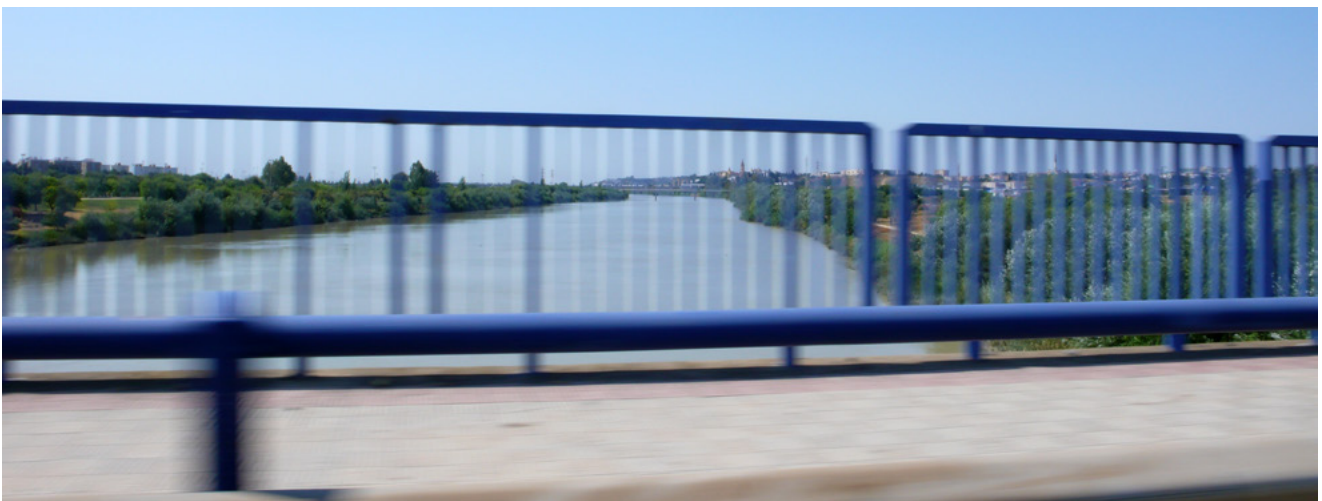
Viaducto sobre el cauce vivo del río en la Corta de la Cartuja. Al fondo, San Juan de Aznalfarache. Autor: José María Rodrigo Cámara.
