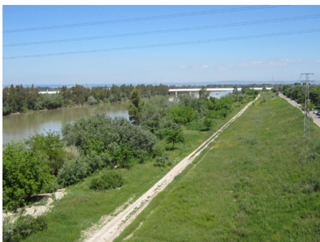
Corta de la Cartuja a la altura de la Isla de la Cartuja en sentido norte. Al fondo, el puente del ferrocarril Sevilla - Huelva.
