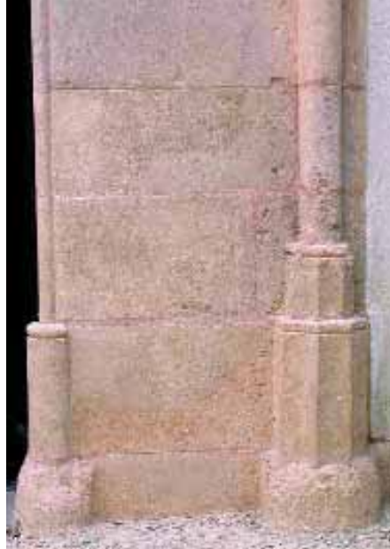
Intervención de restauración realizada con mortero de cal llevada a cabo en la Portada del Convento de la Concepción (Granada). Foto: Ana Luque
