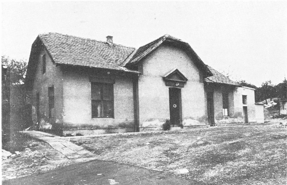
Stara dotrajala zgrada prosekture Zavoda za patologiju u vrijeme prije njena rušenja.
