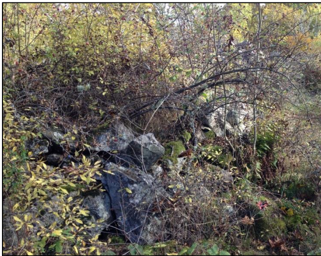
Figur 65. Den kallmurade husgrunden från Båtsmanstorpets. Idag är grundstenarna nästan helt täckta av vegetation. (Foto: Nina Lindberg, 2013-10-08)
