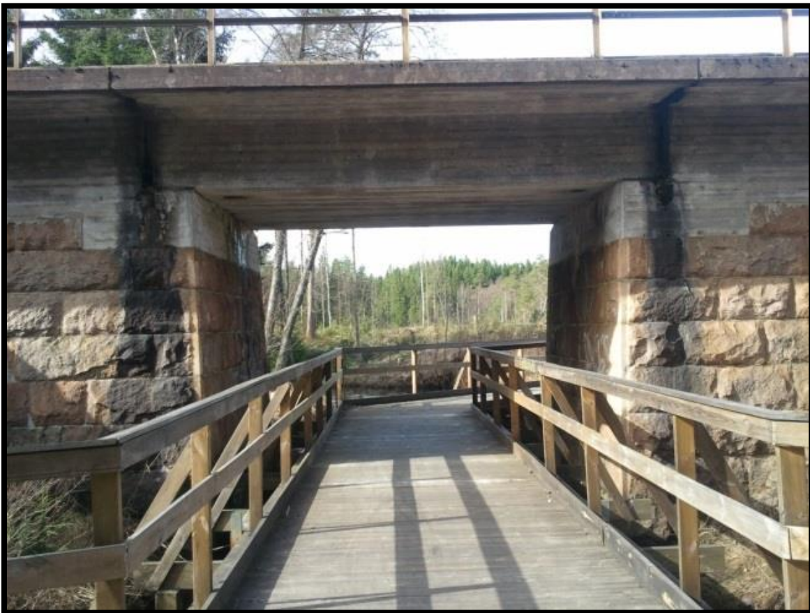
Figur 12 Vänster: Bro under bro vid Isaberg i Småland
