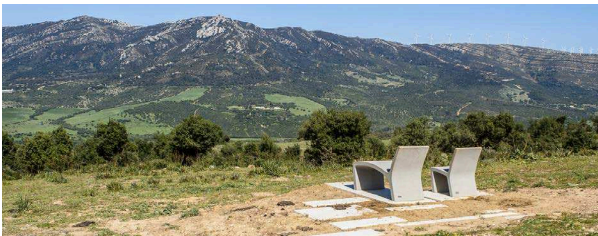
Figura 30. Señalización cultural de tumba antropomorfa tallada en una roca del itinerario (en primer plano) grabada en piezas de hormigón prefabricado que se empotran en el terreno. Fotografía: Jesús Granada.
