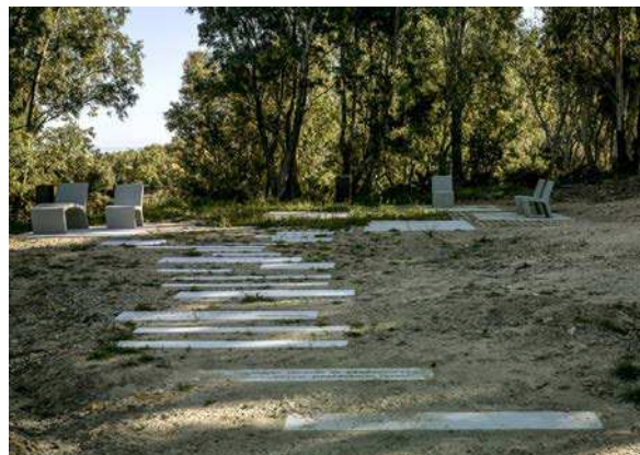
Figuras 31, 32 y 33. Piezas de hormigón prefabricado que conforman puntos de parada y áreas de estancia grabadas durante el proceso de fabricación. Fotografías: Jesús Granada.
