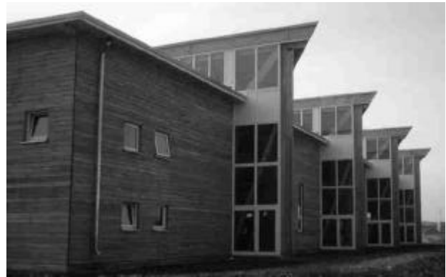
Bild 2: Die Produktionshalle der Hübner GmbH
