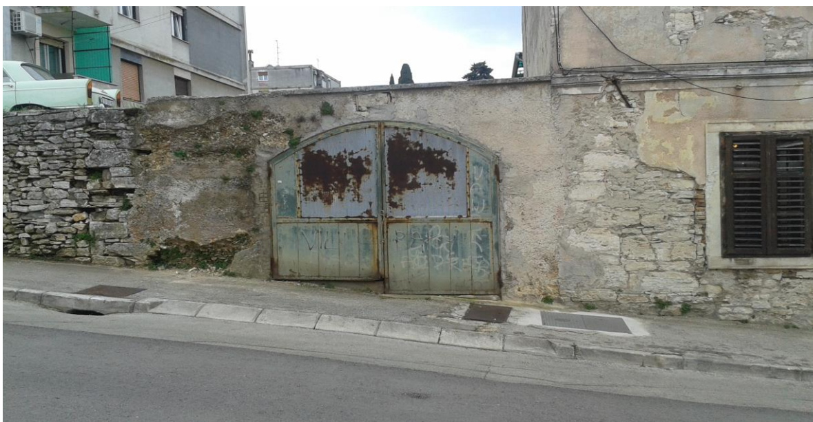
Slika 6. Sporedni izlaz/ulaz u tunel br.19 (Izvor: autor)
