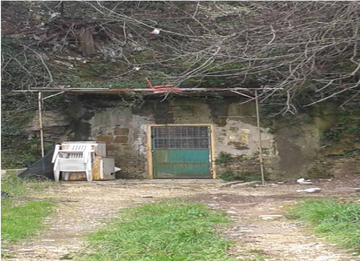
Slika 5. Ulaz u tunel br. 19 (Izvor: autor)
