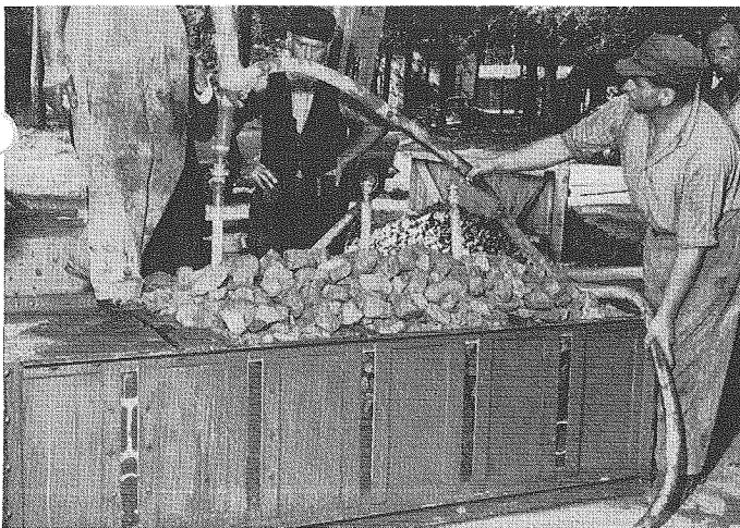
Bild 7. Fließen des Mörtels im Grobzuschlag
