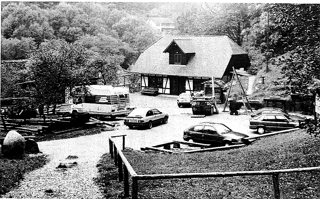
Grubenvorplatz auf der Halde mit Blick nach Südosten. Mundloch rechts am Bildrand.
