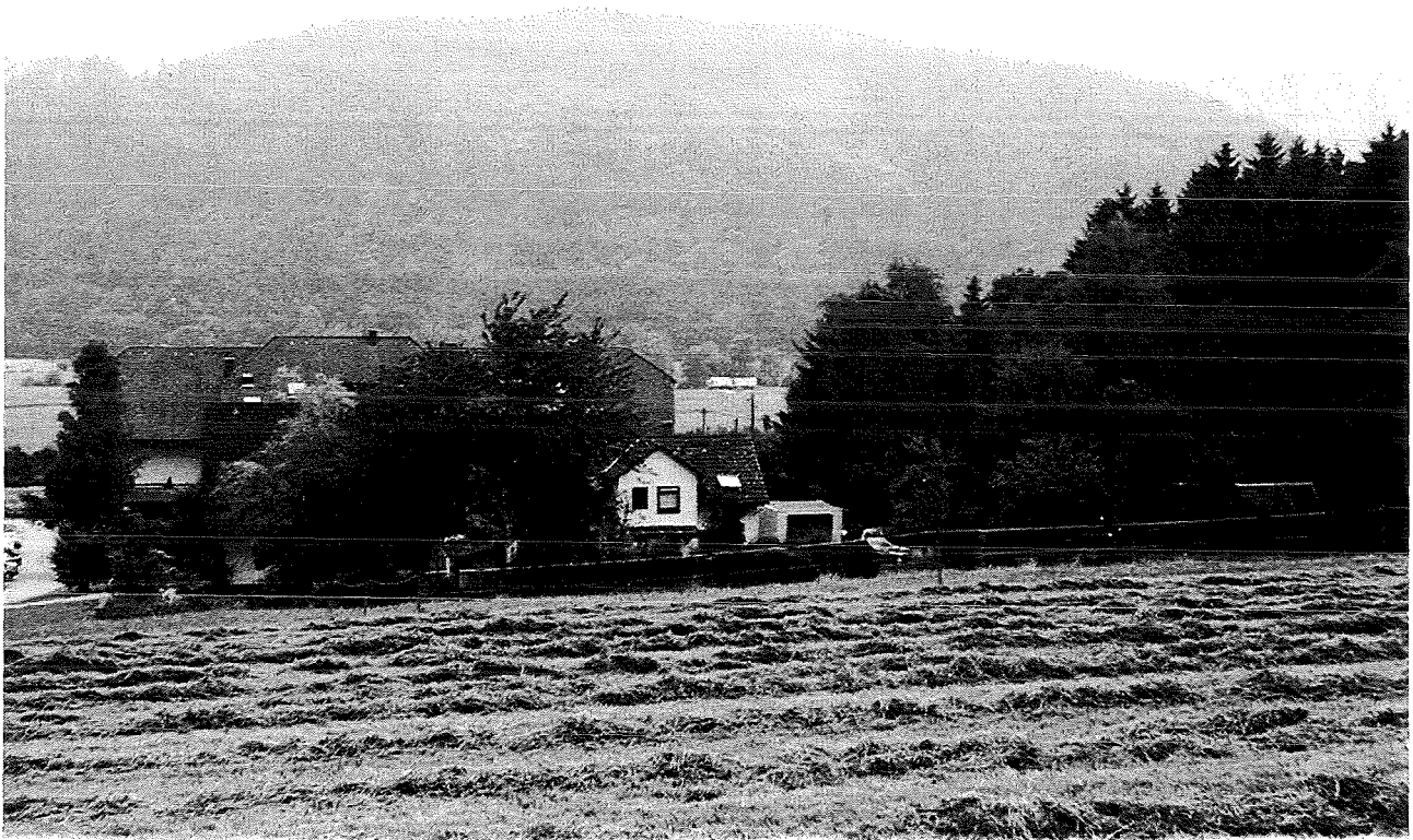
Bereich der ehemaligen Aufbereitung und der Schachtanlage (vergl. bei BL 86, Abb. 145, S. 675)
