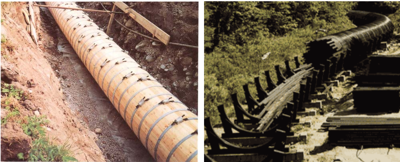
Abb. 2 Druckrohrleitungen aus Holz (a) im Graben und (b) auf Sätteln verlegt (von Zwick Holzbau GmbH, Canbar Inc.)
