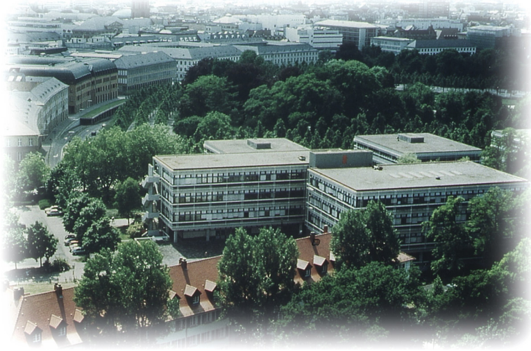
Abb. 2.1. Rechenzentrum der Universität Karlsruhe (TH) (Foto: RZ)
