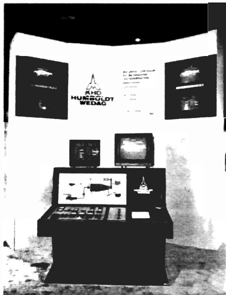
2: Der Schaltschrank (Gesamtansicht)
