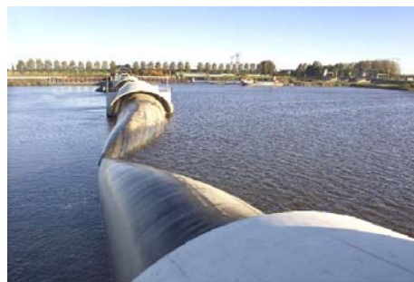
Bild 3: Ausbildung einer V-Kerbe als typisches Stabilitätsversagen eines Schlauchwehres
