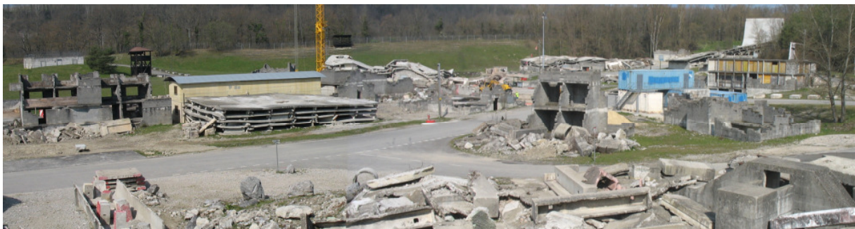
Abbildung 1: Zerstörte Gebäude auf dem Übungsgelände Epeisses
