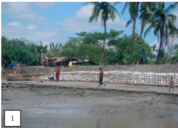
Abbildung 4.10: (1) Wiederaufbau eines Bambuszauns und Sandschüttung (2) Gebrochener Deich Foto: B.Mallick, 2010
