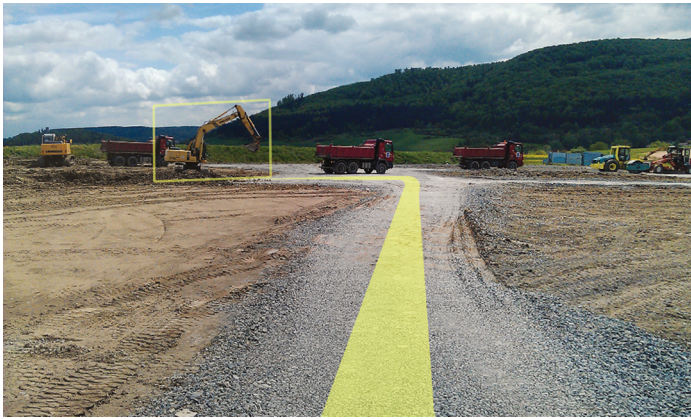
Abbildung 5.10: AR-Navigationsgerät auf der Baustelle
